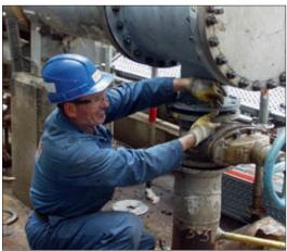
Überall in der chemischen Industrie werden Schrauben für die Verbindungen der unterschiedlichen Komponenten verwendet. So waren z. B. beim routinemäßigen Shutdown der OMV Raffinerie in Schwechat, Wien im Herbst 2005 ca. 130.000 Schrauben zwischen M5 und M130 an Rohrleitungen, Mess- und Regeleinrichtungen, Ventilen, Armaturen, Tanks und Behältern, Wärmetauschern zu lösen bzw. zu überprüfen. Dabei muss als wesentlicher Zeit- und somit
