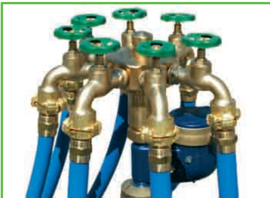
Schlauch stimmt, Kupplung auch. Die Schlauchleitungen dürfen eingesetzt werden.
